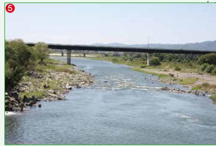
5 藤崎頭首工下流で新竜門橋上流にあたる場所。解禁当初からの実績も高い。瀬肩から瀬落ちのチャラ瀬までがポイント。頭首工横の左岸に駐車場があり左岸からも入川可能
