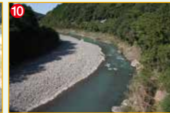
10 岩倉発電所の放水口から近いので水温が低い。8月ごろからよく釣れる。放水口から上流50m、下流100mは禁漁
