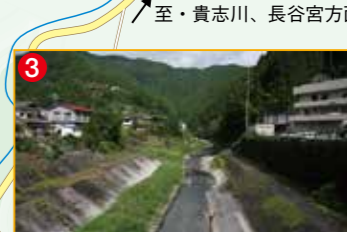
3 梁瀬大橋の上流。このト口場によくアユが溜まる。写真左の建物が花園温泉
