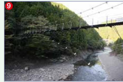
龍神橋上下流。下流は岩が多く淵もあり変化に富んだ川相で面白い。上流は小砂利が多い
