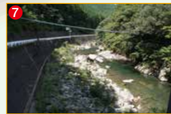
⑦ 江口橋の上流側。ここから50mほど下で安川と合流する
