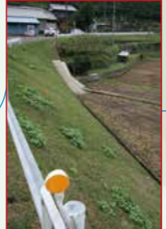
下地橋の東詰、農道を通って入川する
