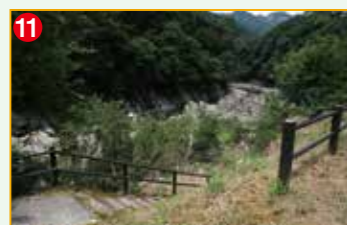
11 小さな流れ込みに架かる瀨井谷橋手前に駐車スペースと手すり付きスロープと階段がある
