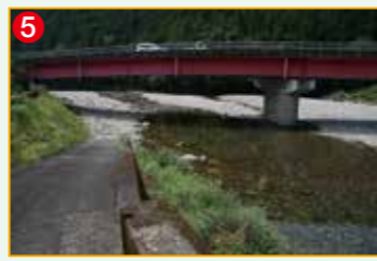
5 橋の手前から旧道を進むと入川できるスロープがある
